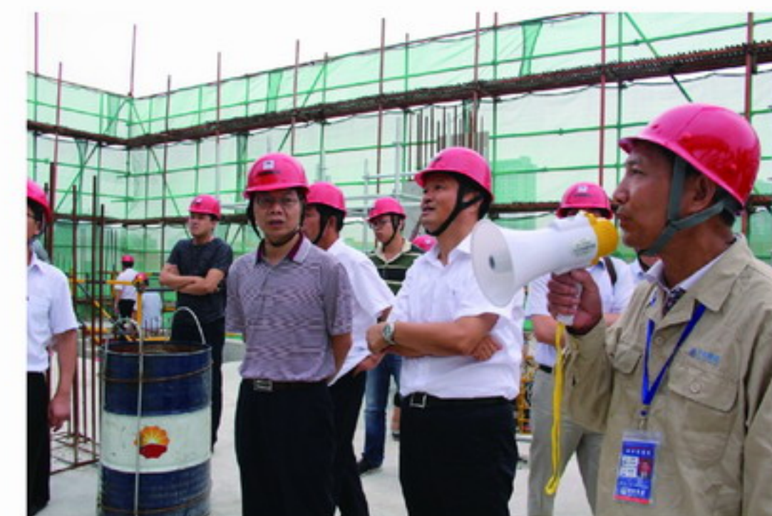
龙馨家园观摩PC吊装施工技术
