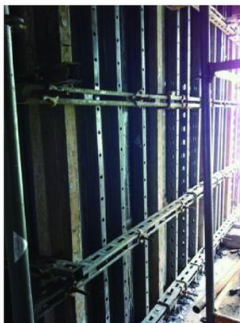
轻钢钢楞墙板支模
