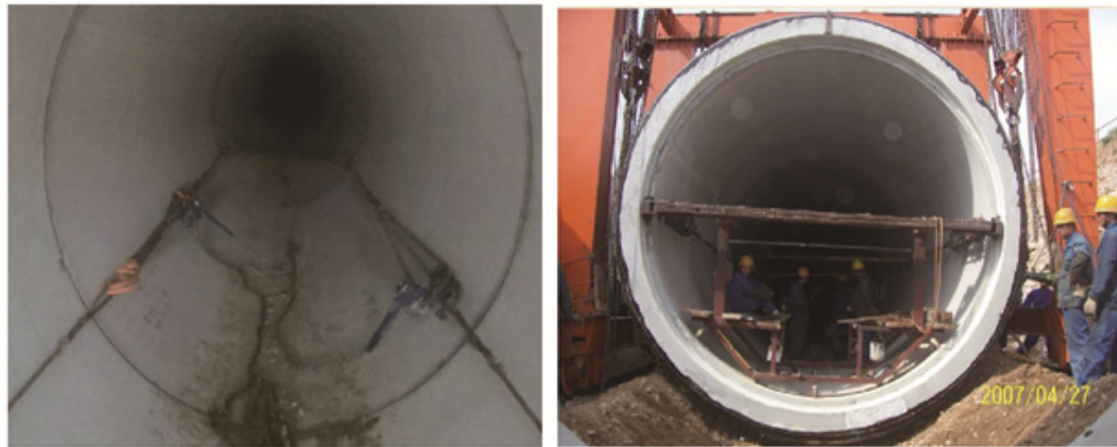
手拉葫芦对接内拉法实例
